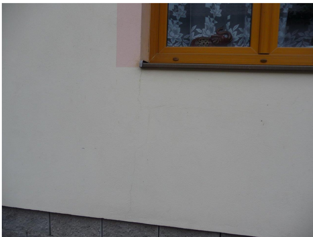
Foto č. 22 - Fasáda – trhlina pod oknem
