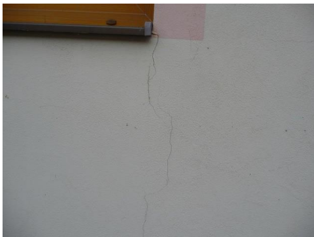
Foto č. 23 - Fasáda – trhlina pod oknem - detail
