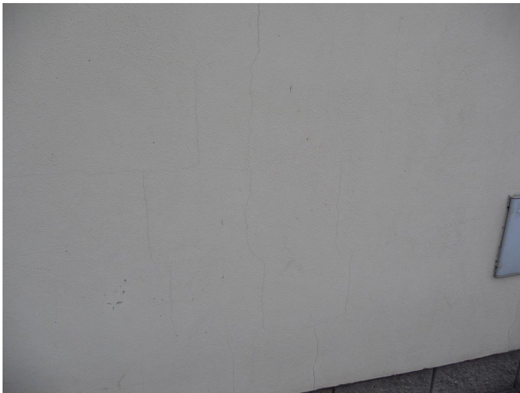
Foto č. 24 - Fasáda – trhliny pod okny
