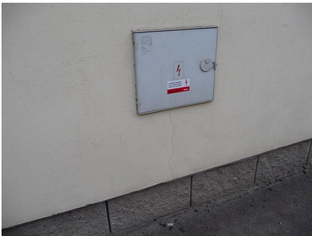
Foto č. 25 - Fasáda – trhlina pod el. skříní
