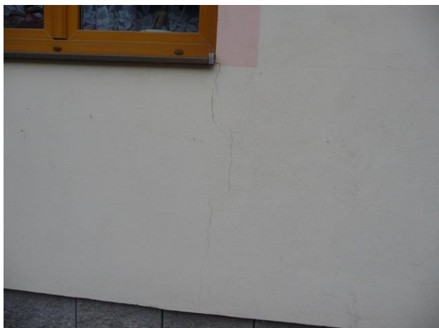
Foto č. 21 - Fasáda – trhlina pod oknem
