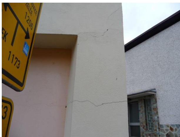
Foto č. 27 - Fasáda – trhlina u vrat do garáže
