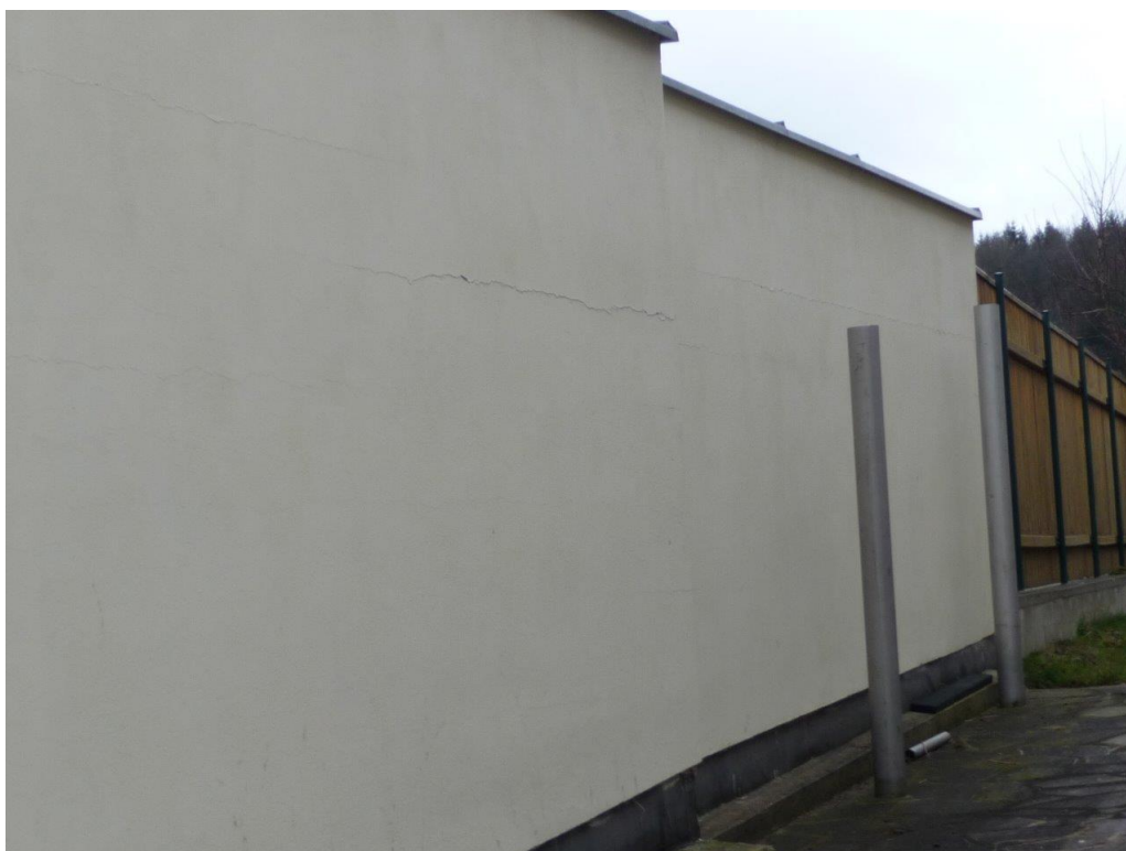
Foto č. 28 – Fasáda severní – garáž - trhlina
