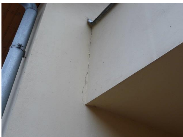
Foto č. 26 - Fasáda – trhlina nad vstupem
