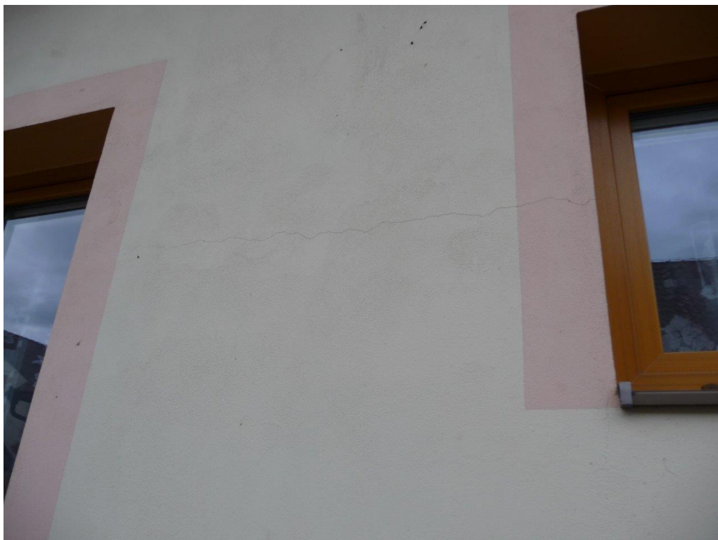
Foto č. 20 - Fasáda – trhlina mezi okny
