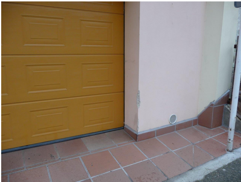
Foto č. 17 – Fasáda – garáž – poškozený roh
