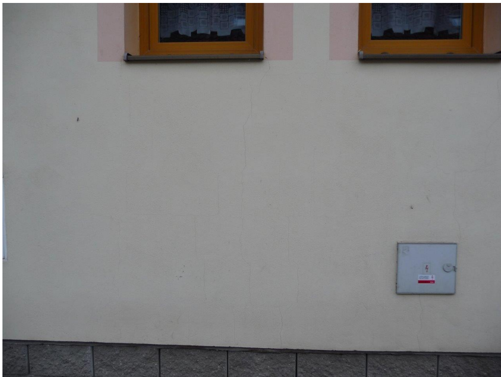
Foto č. 18 - Fasáda – drobné trhliny
