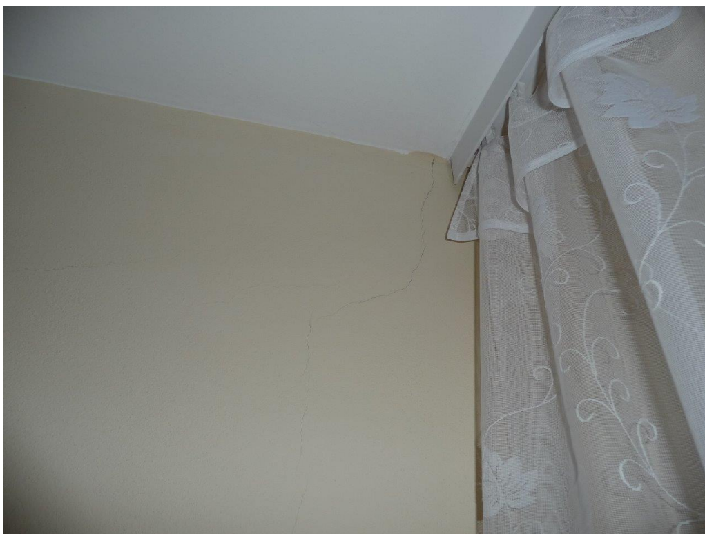
Foto č. 2 – Chodba v podkrovní – trhlina u stropu
